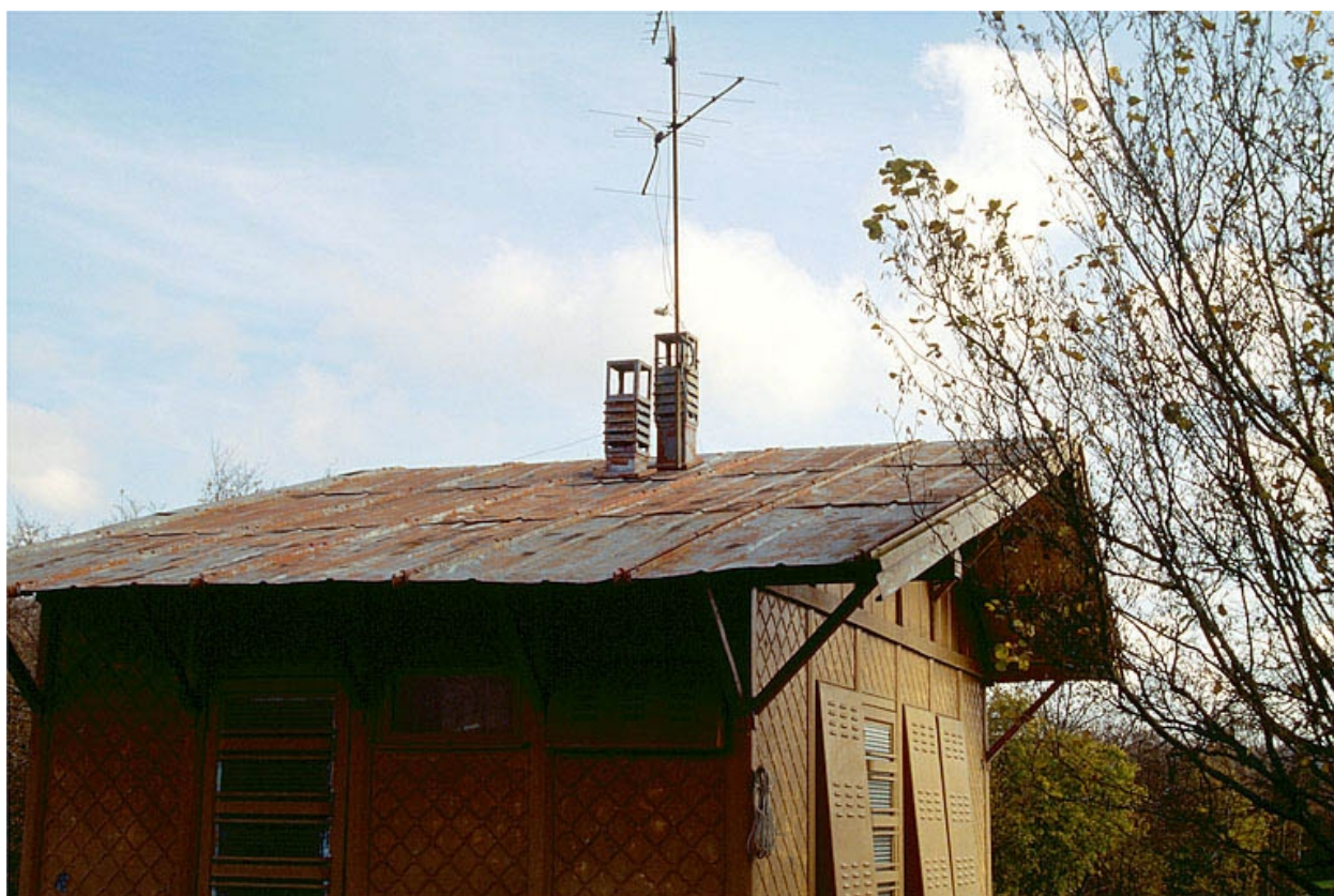
Toiture et cheminées.
