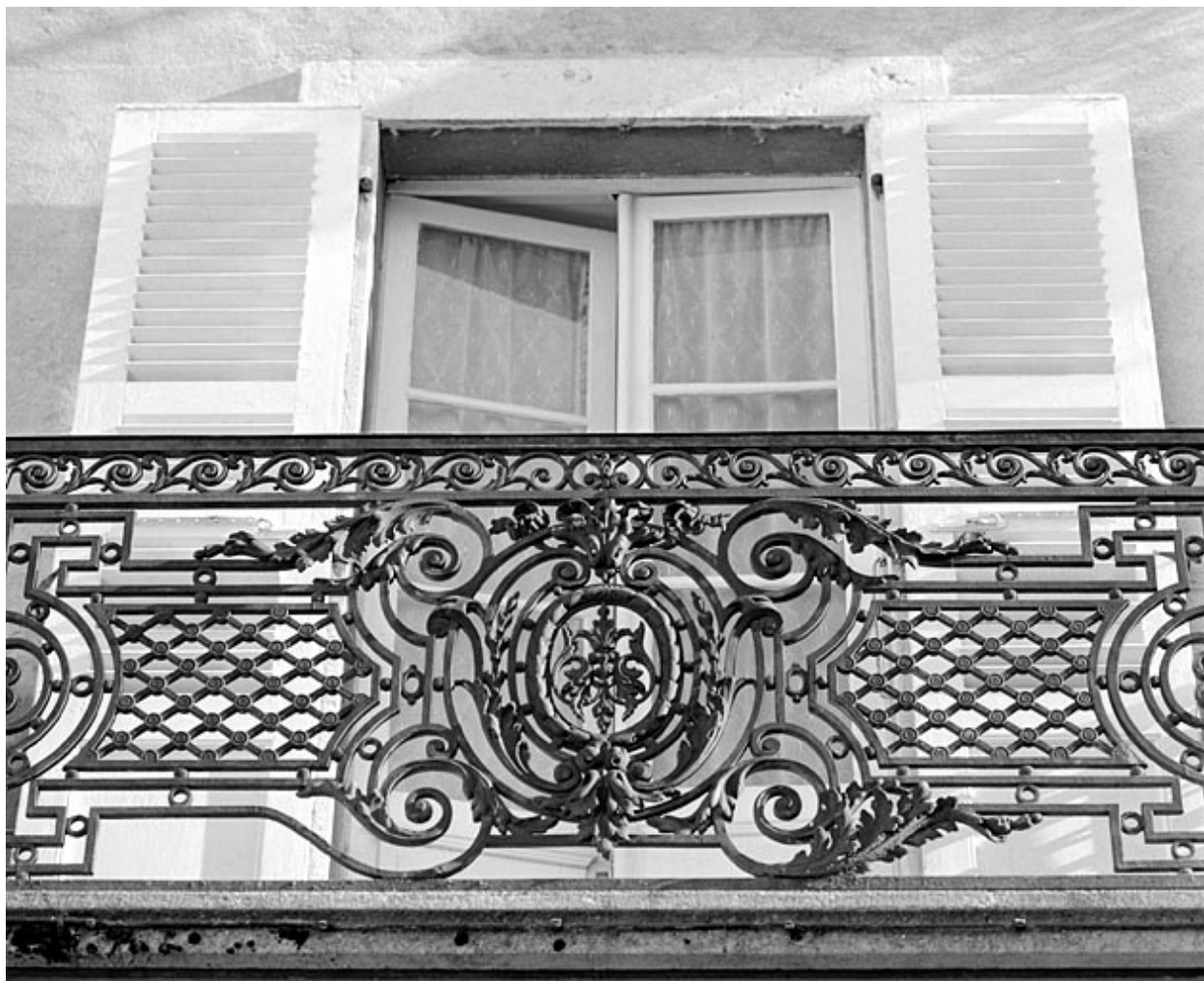
Balcon du premier étage : détail du garde-corps.
