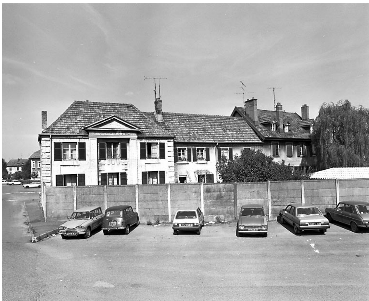
Audincourt : maison située 14 rue de la Cour de l'Orangerie.
