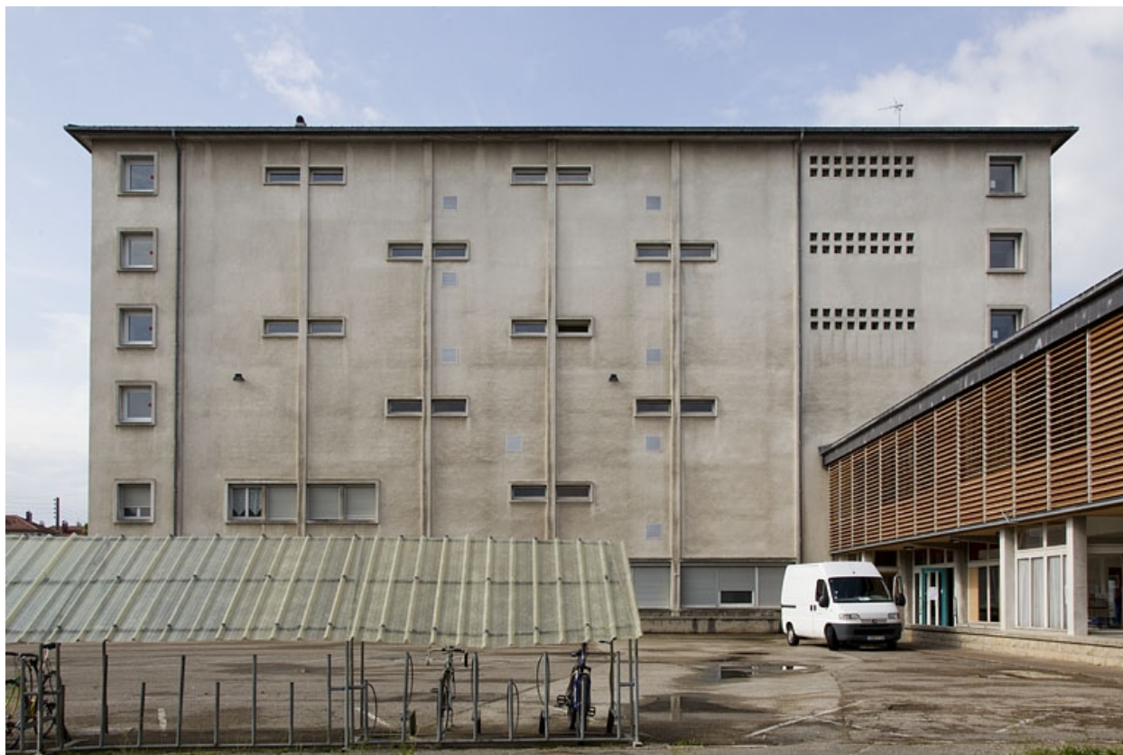
Internat garçons, vu du nord.
