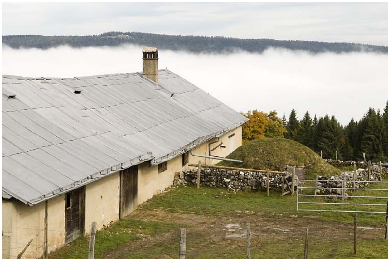
Façade antérieure vue en enfilade et citerne.
