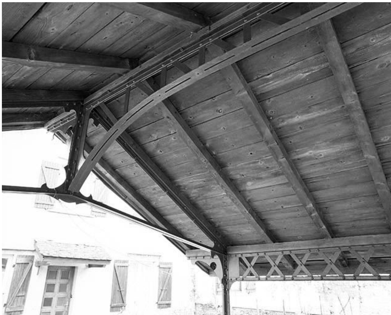
Charpente métallique : faîtage et sablière.
