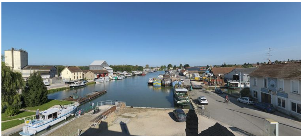
Vue d'ensemble du port prise d'aval.
