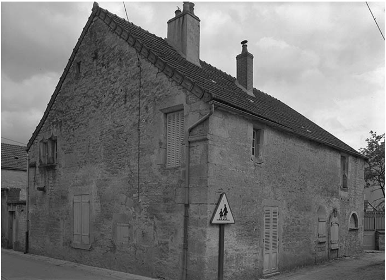
Mur-pignon et façade latérale.
