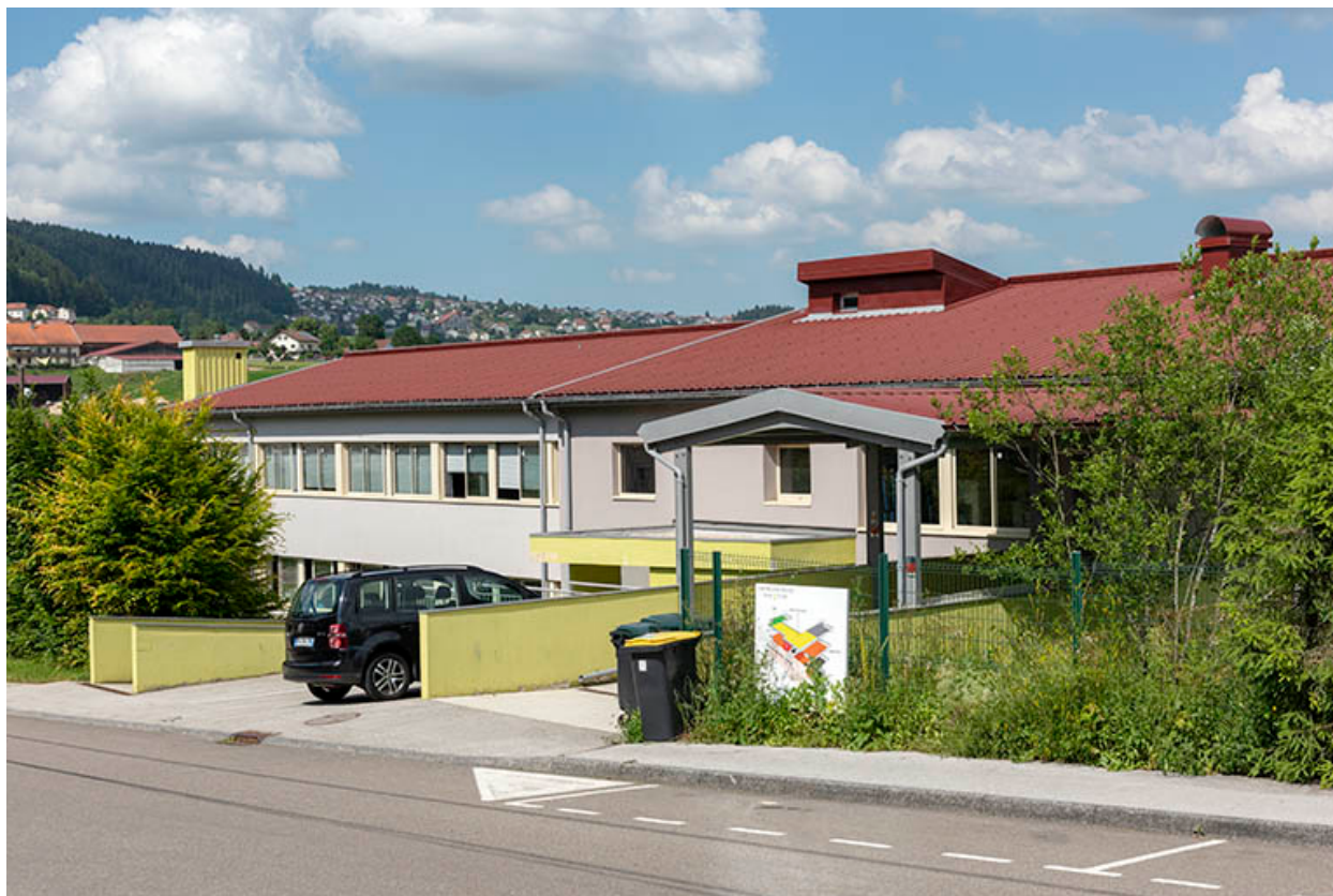
2e bâtiment, vu du sud-ouest.
