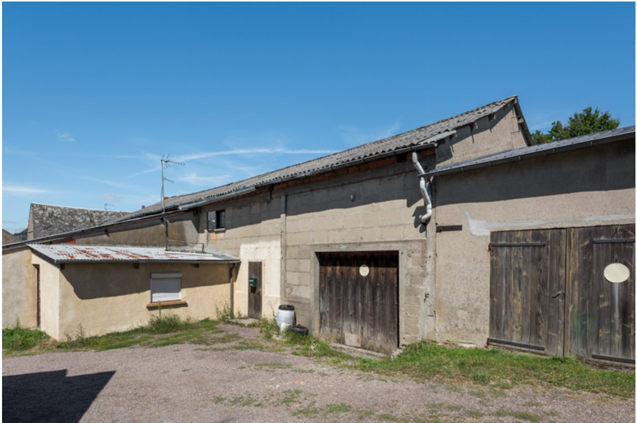
Façades latérale droite et postérieure (la salle).
