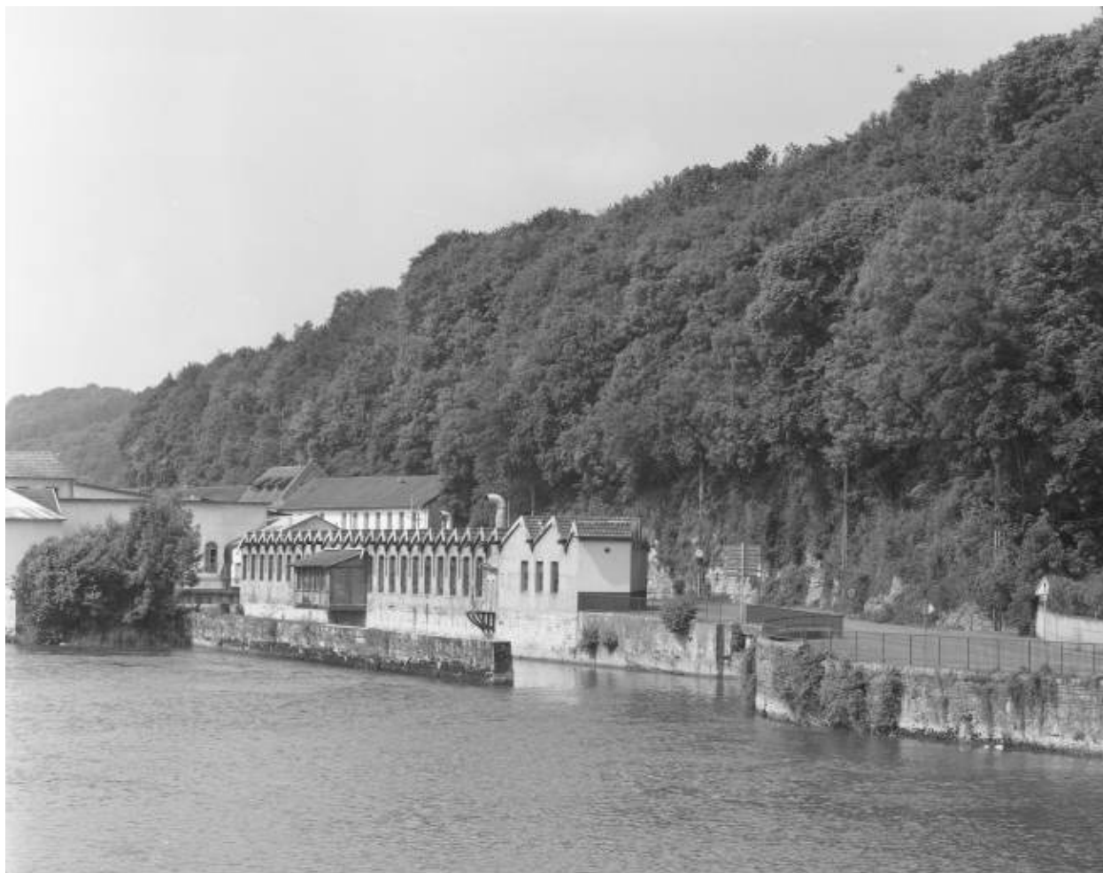
Vue d'ensemble depuis le pont. Vue rapprochée.
