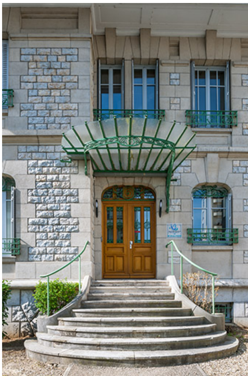
Façade antérieure : perron, entrée et marquise.
