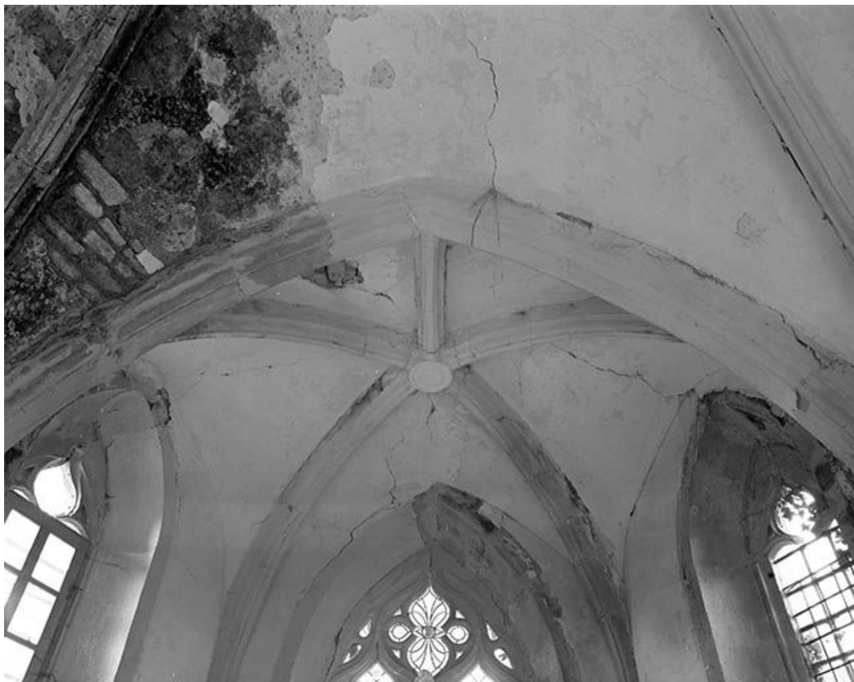
Intérieur de la chapelle : voûte du choeur.
