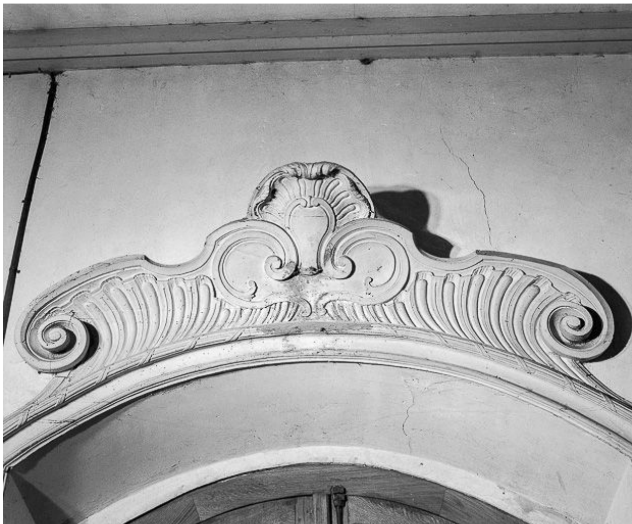
Intérieur : couronnement de la porte d'entrée.
