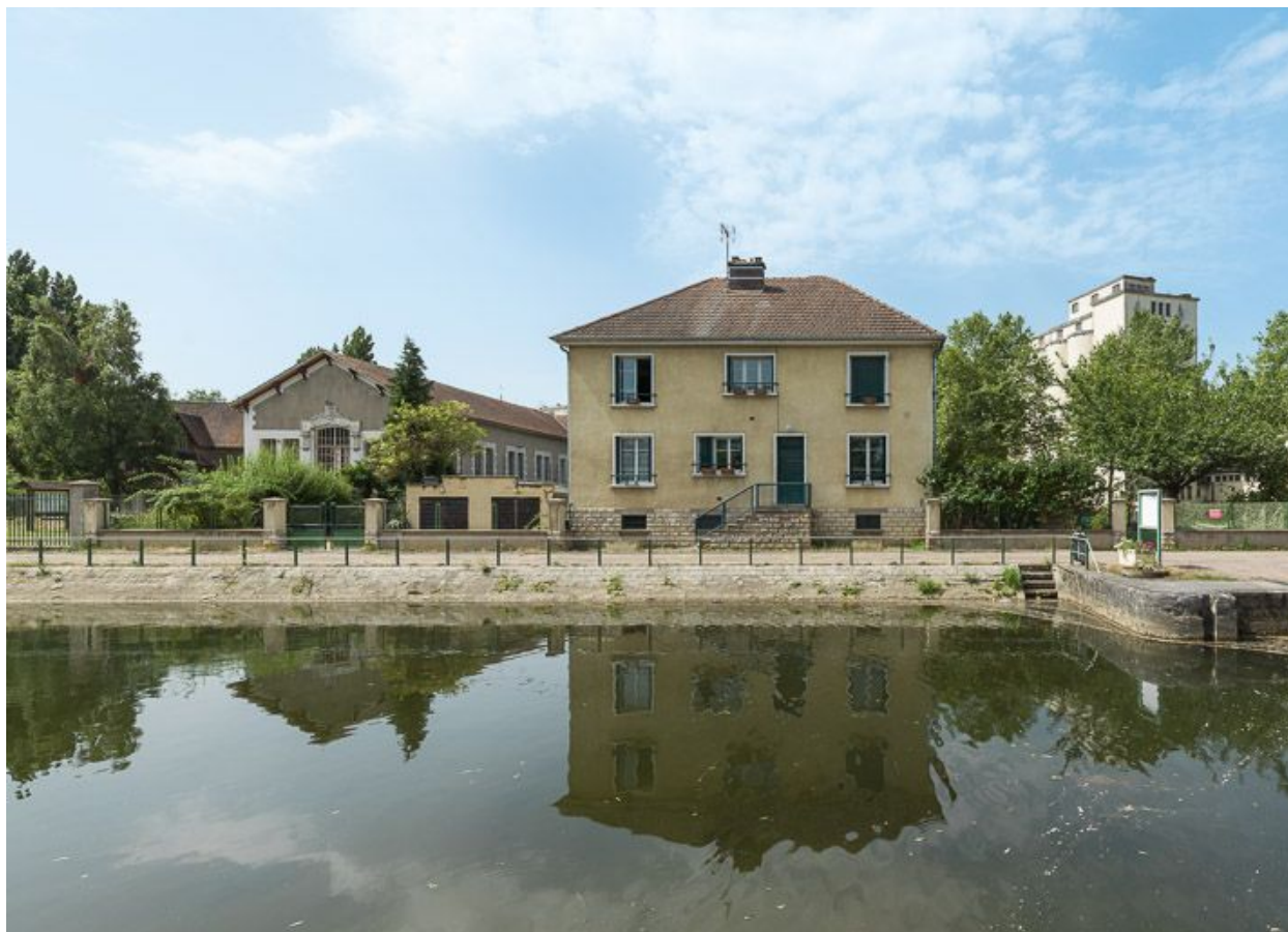
Vue de la maison éclusière, de face.
