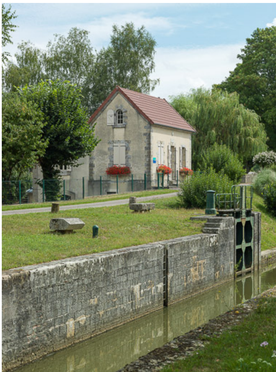
Vue de la maison éclusière.
