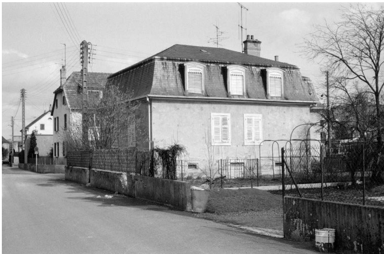
Façades postérieure et latérale droite.
