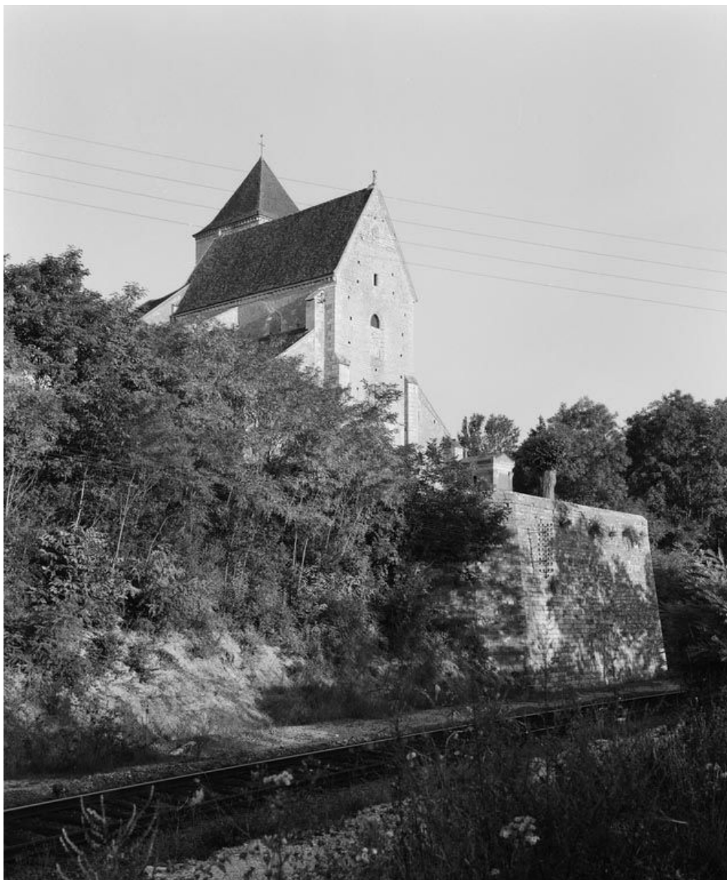
Vue d'ensemble, prise du canal.
