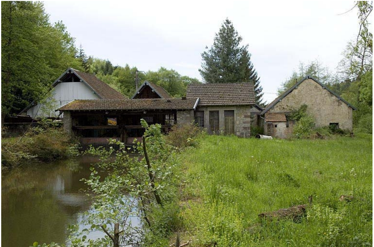
Façades postérieures depuis le bief d'amenée.
