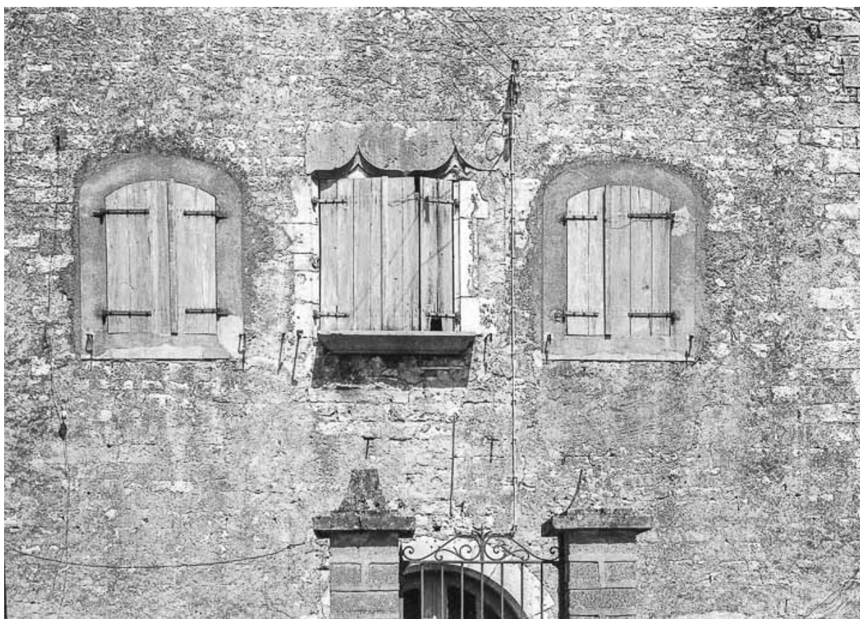
Valay, maison située rue Fénelon : exemple de mur en moellons calcaire recouverts d'enduit.
