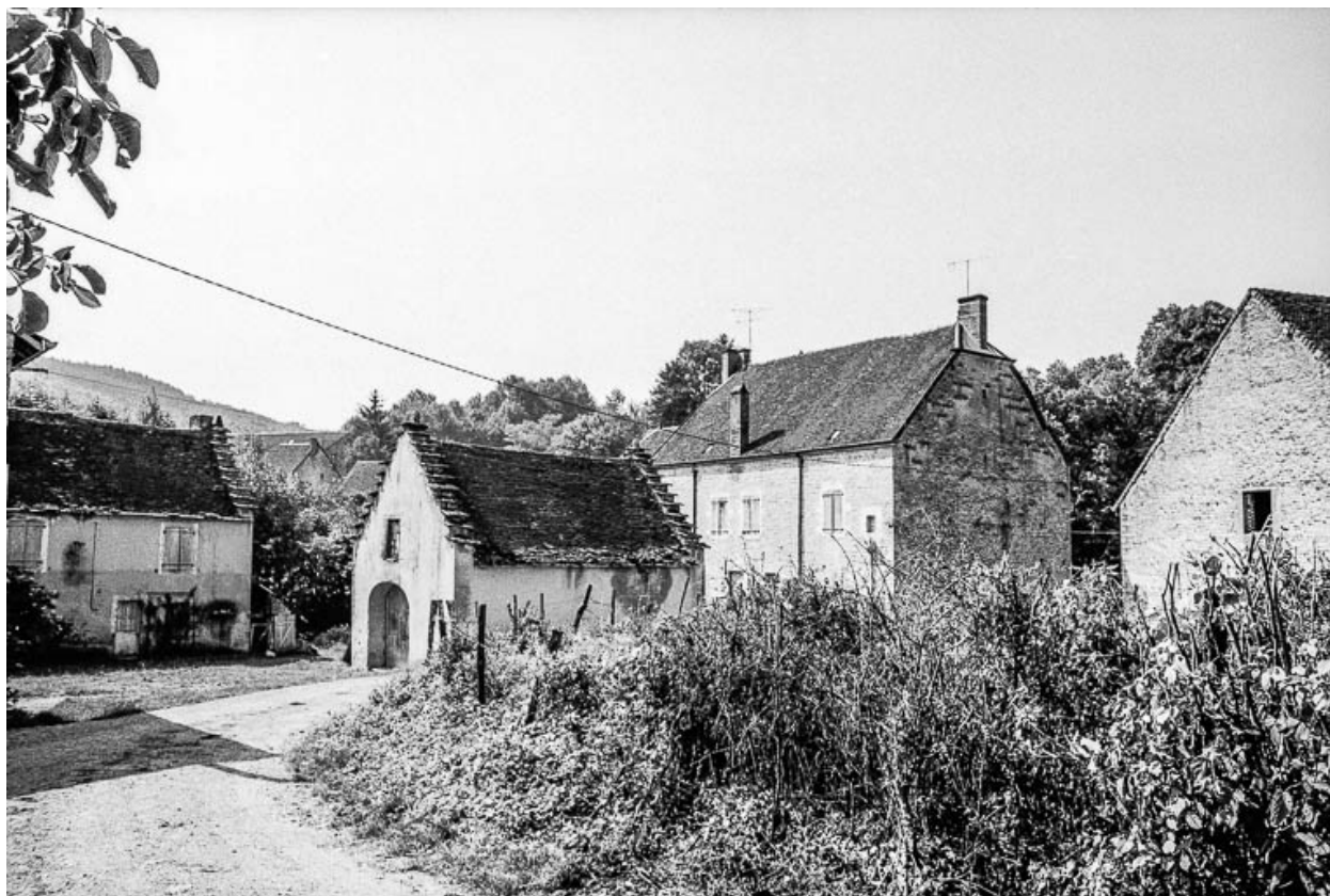
Maison cadastrée 1964 AC 182 : vue d'ensemble.
