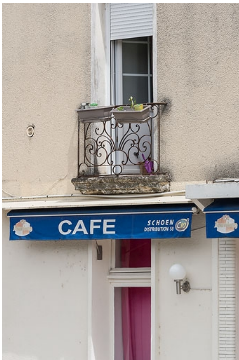
Garde-corps du 18e siècle.
