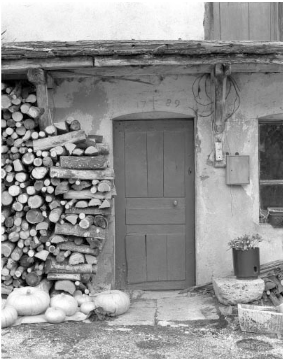
Porte d'accès au logis.
