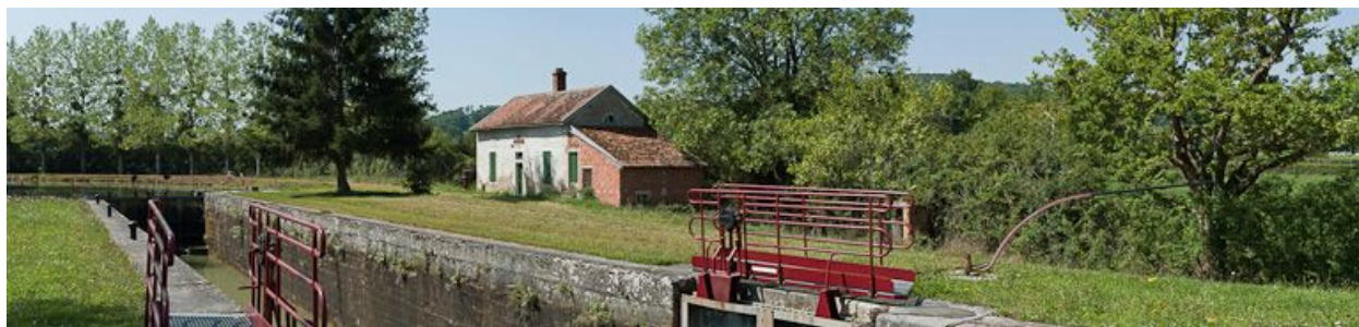
Vue d'ensemble du site d'écluse.
