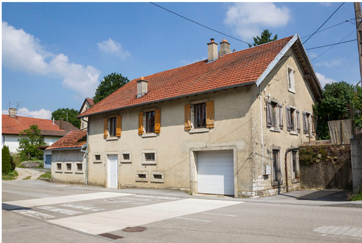
Ancienne fromagerie, de trois quarts droite.
