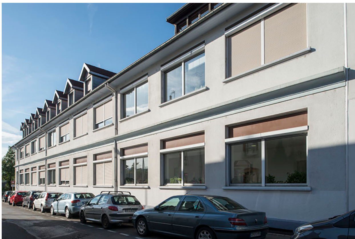
Détail de la façade.
