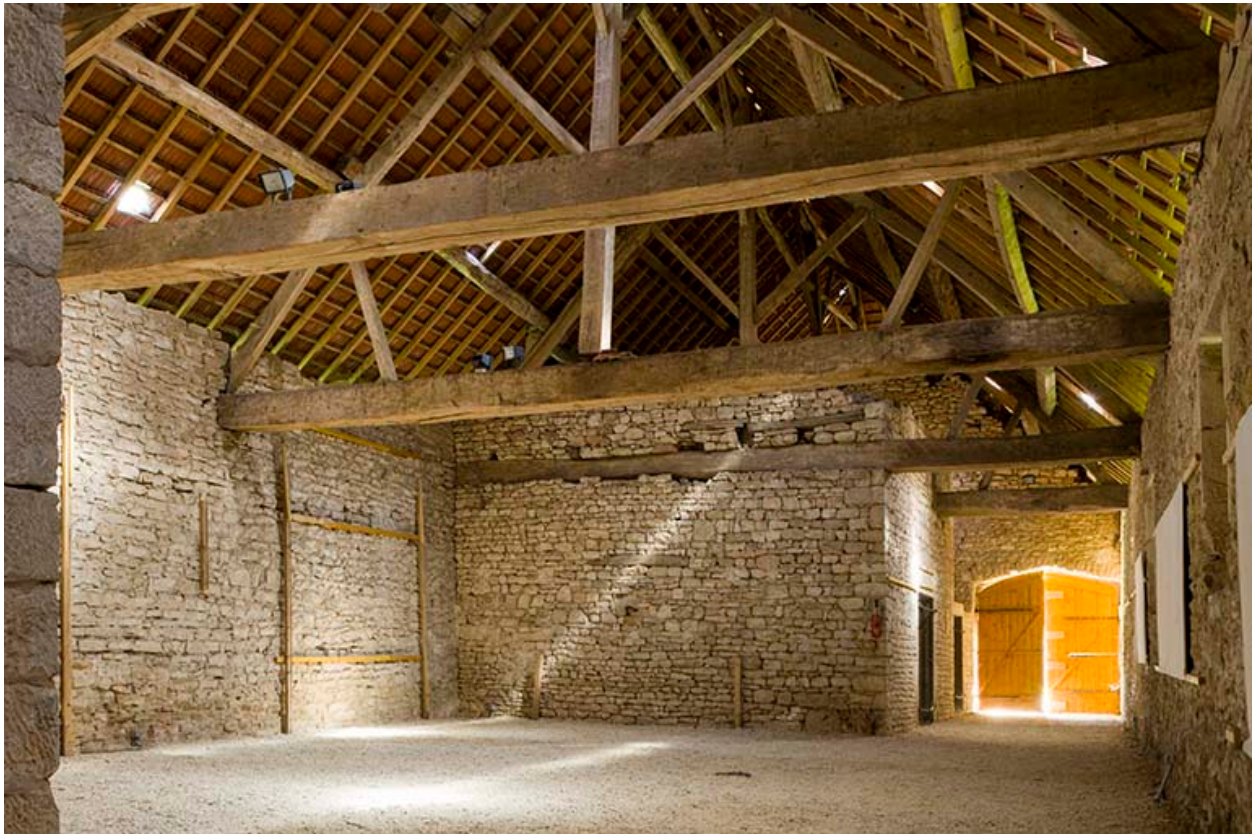
Intérieur du cuvage, en direction du sud-est.
