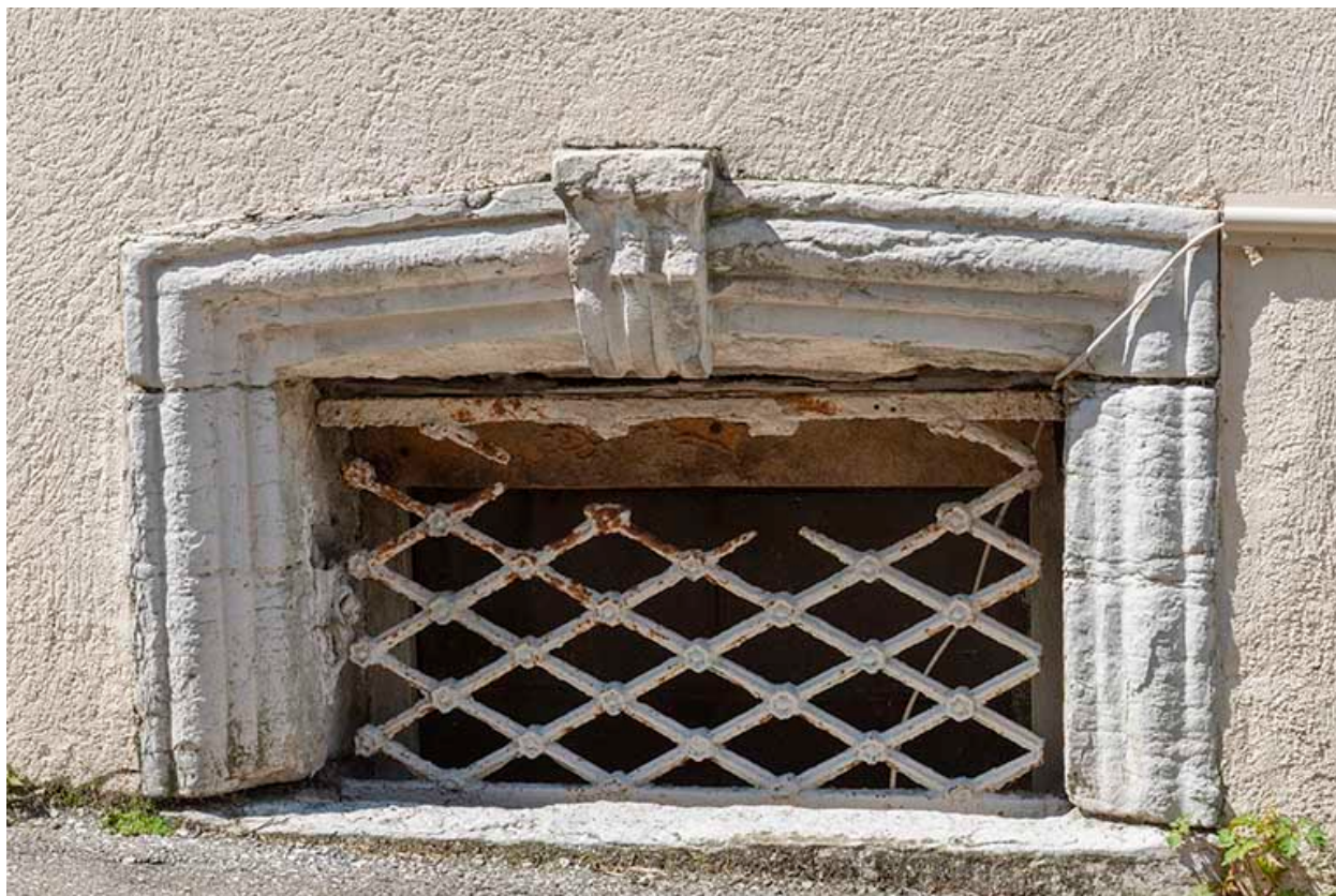
Façade antérieure. Soupirail.
