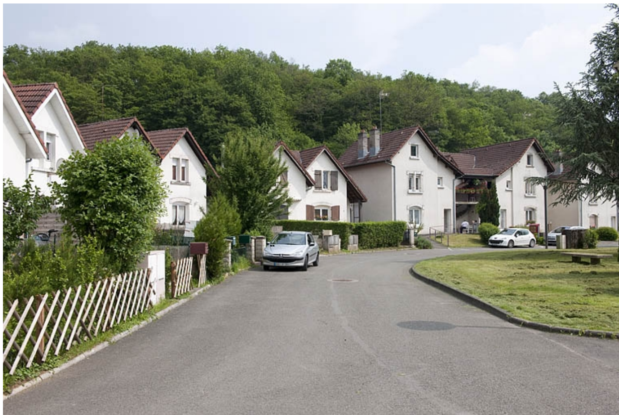
Cité du parc. Vue d'ensemble depuis l'entrée.
