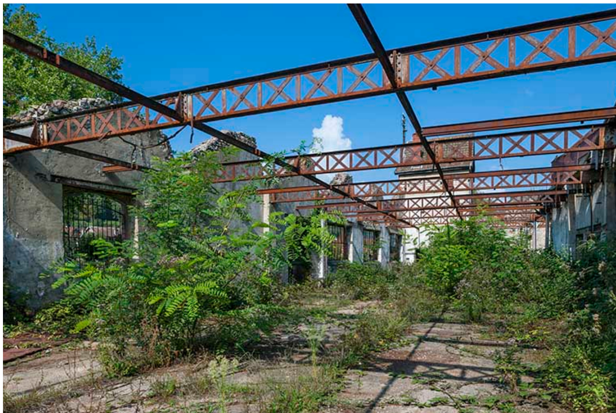
Vue Intérieure de l'atelier de fabrication.
