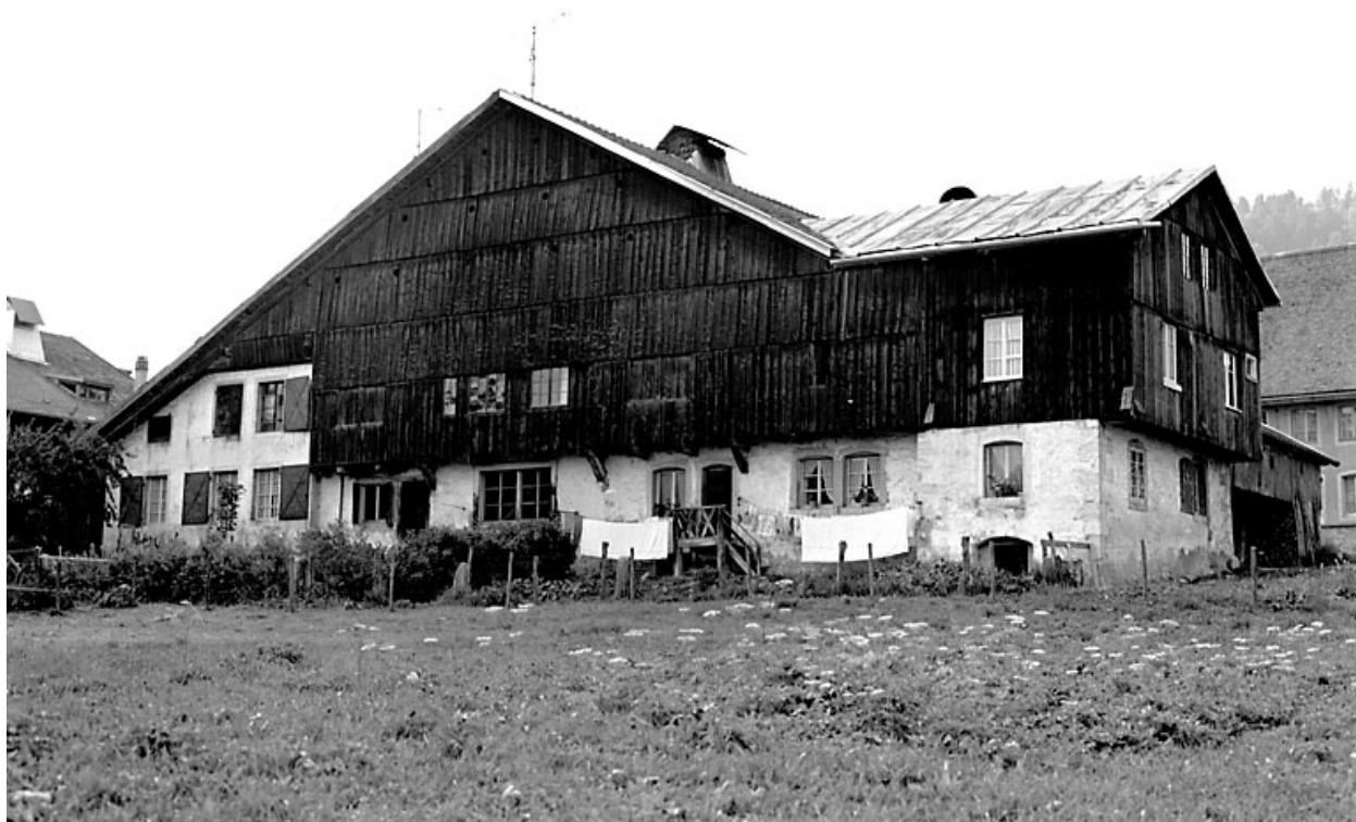
Grand'Combe Châteleu : ferme 3 située au lieu-dit Les Cordiers.
