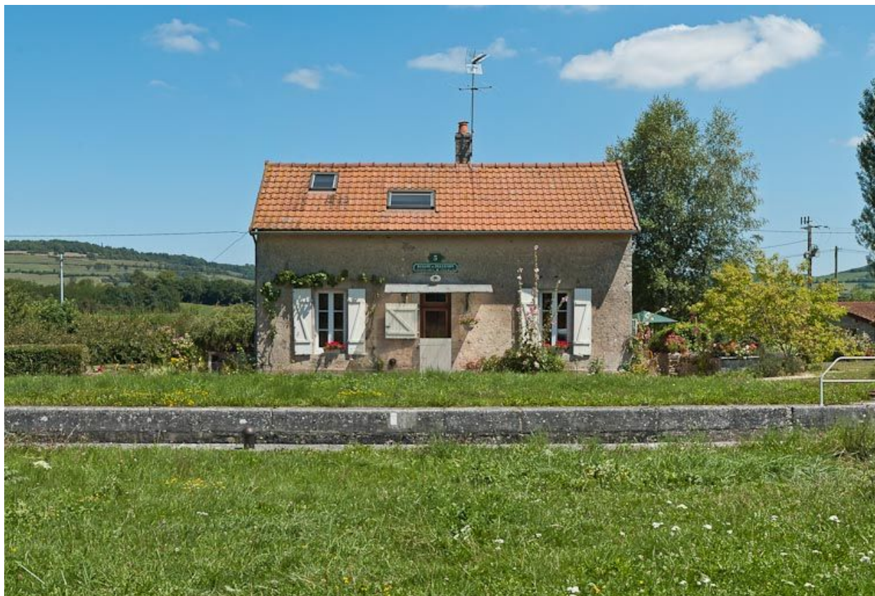
Vue de face de la maison éclusière.
