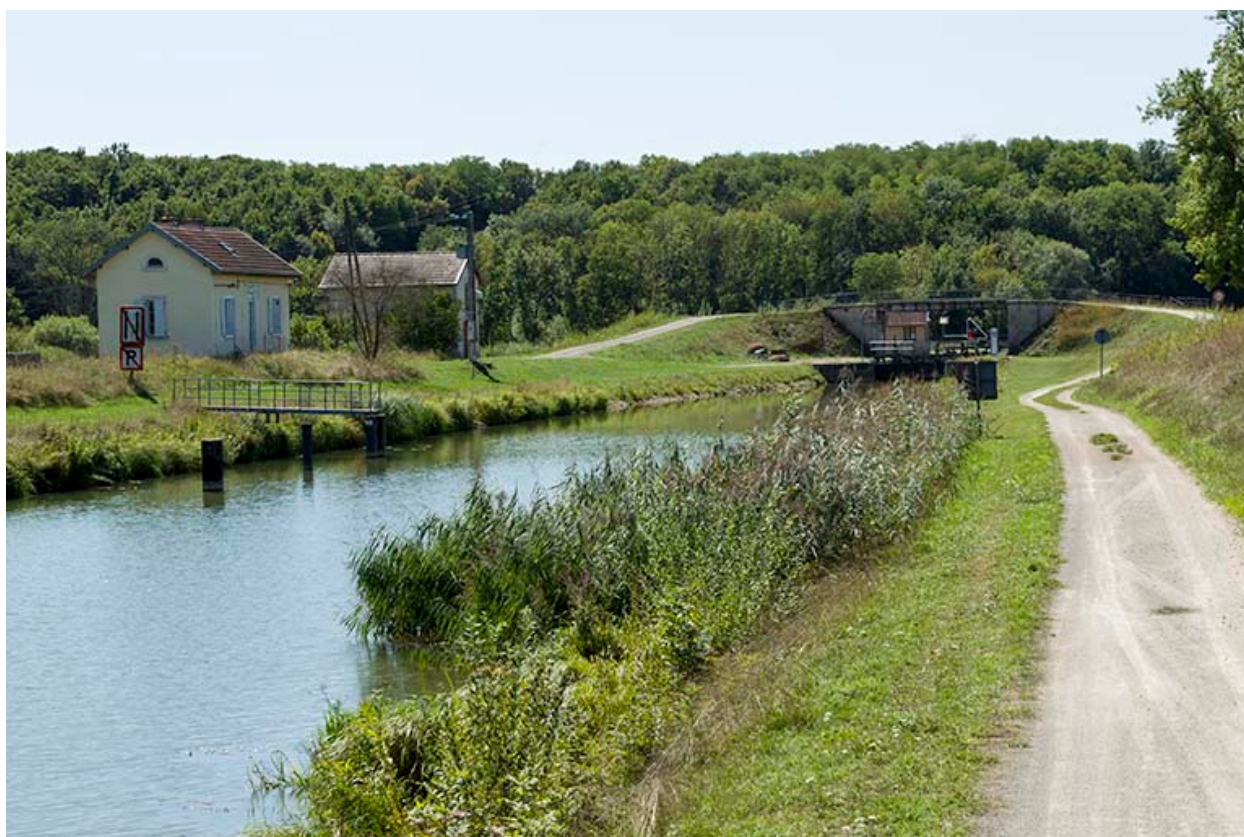
Vue générale du site d'écluse.
