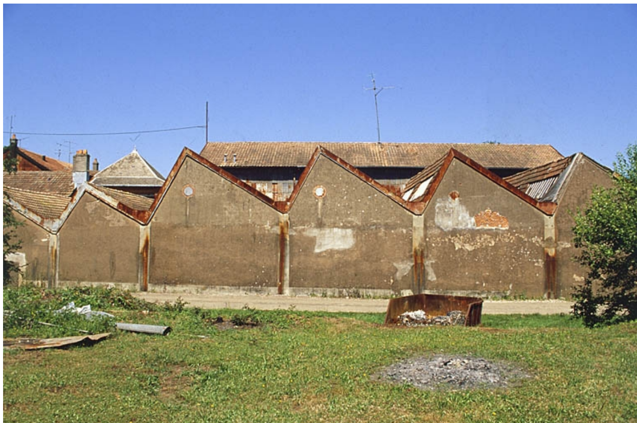
Pignons des sheds au sud.
