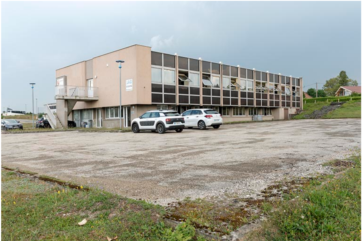
Façades postérieure et latérale droite.
