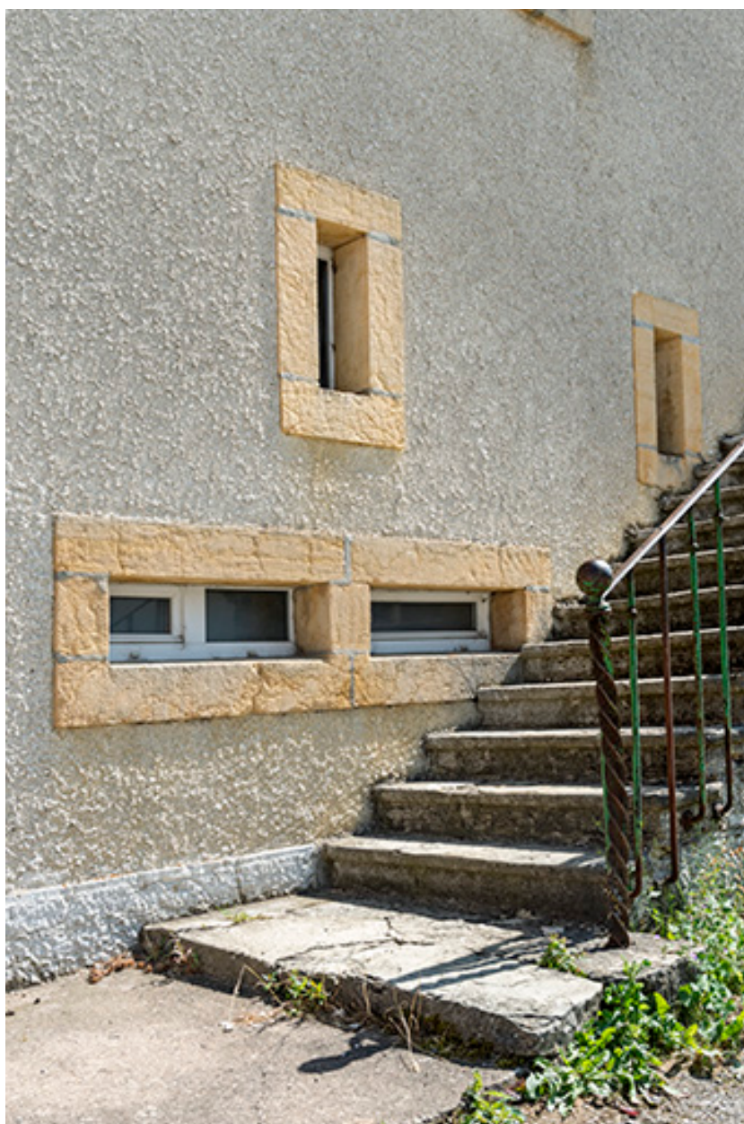
Baies fromagères horizontales sur la façade nord.
