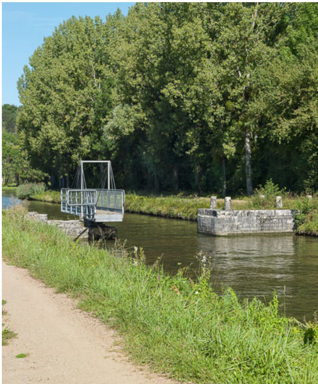
Vue d'ensemble de la passerelle.
