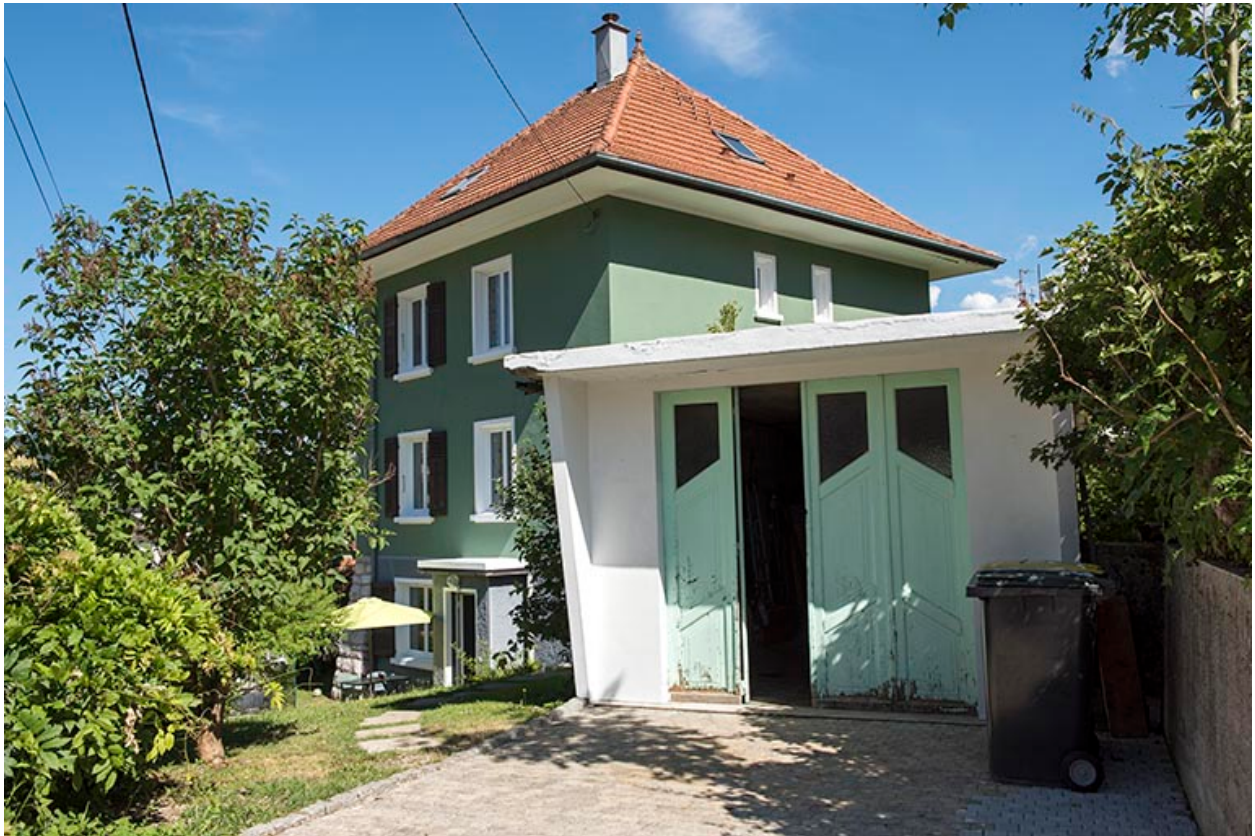
Garage et façade latérale droite.
