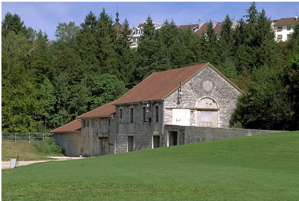
Ateliers de fabrication (galvanisation).
