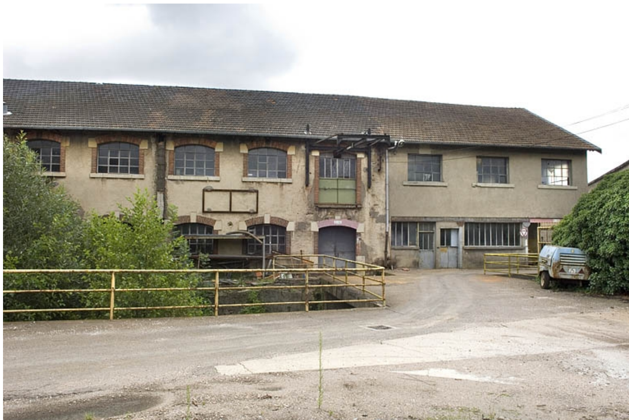
Façade ouest d'un atelier de fabrication (papeterie).
