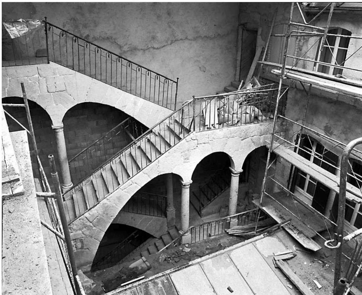
Escalier sur cour intérieure.
