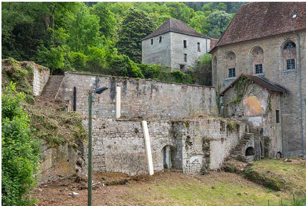
Terrasses maçonnées (emplacement des bâtiments).
