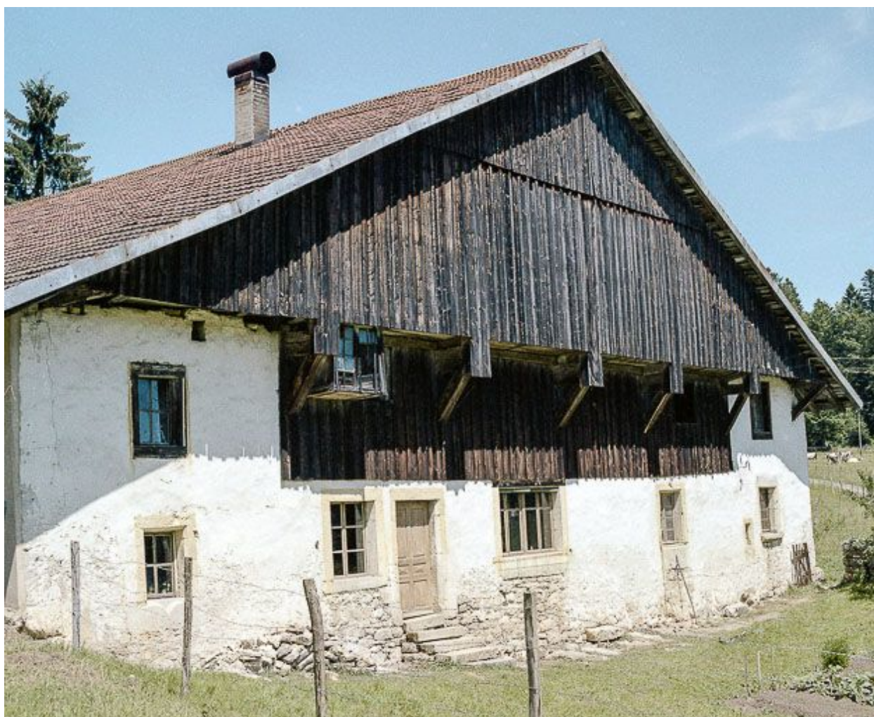
Façades antérieure et latérale droite.
