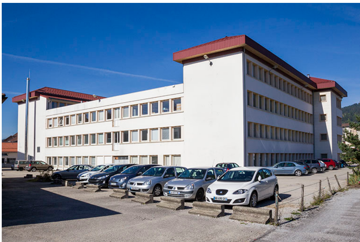
Usine : façades postérieure et latérale gauche.
