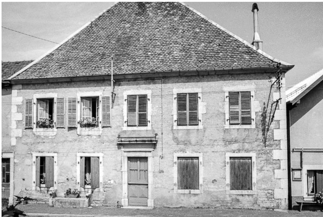
Ferme cadastrée 1962 E 80 : façade antérieure.
