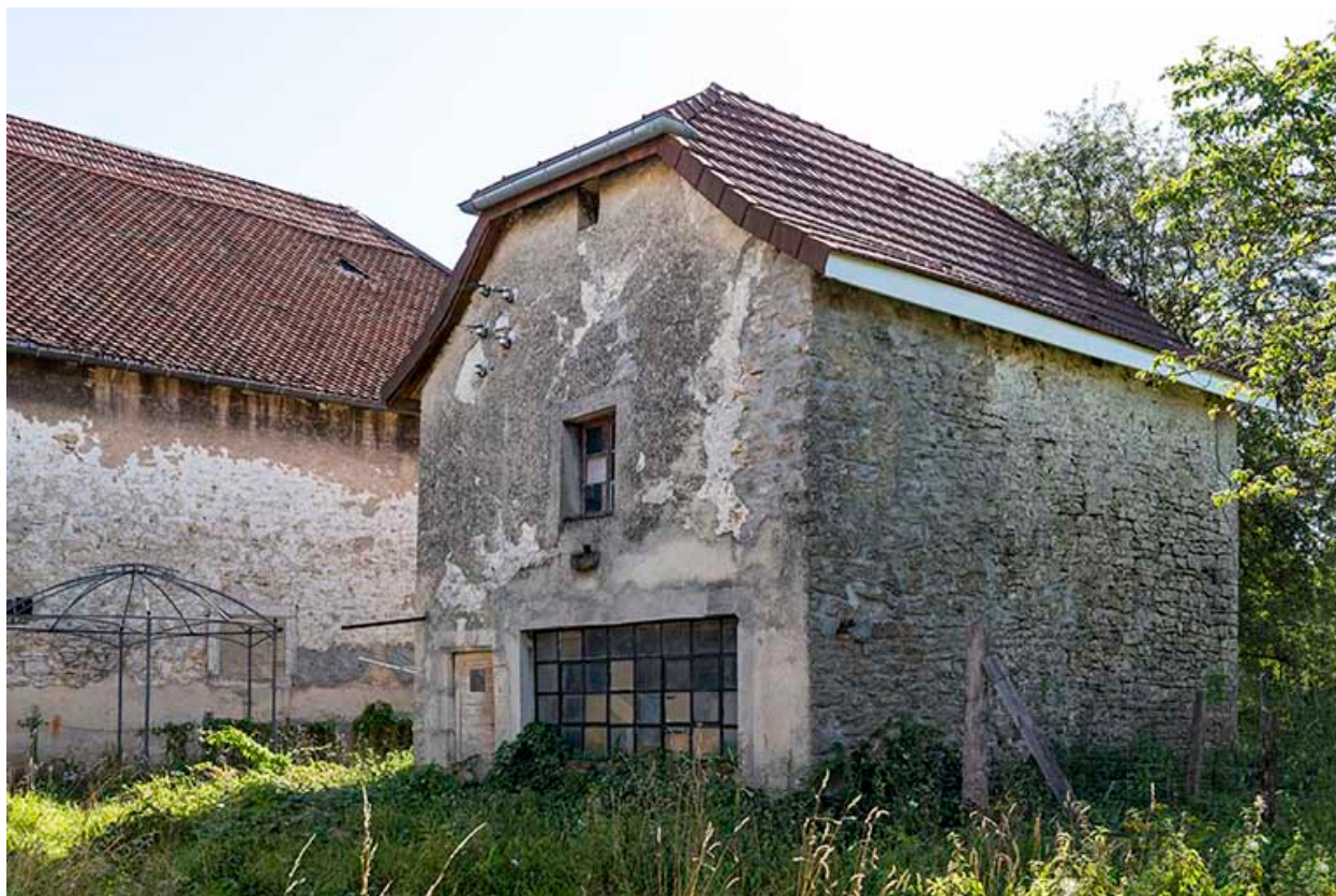
Forge : façades antérieure et latérale droite.
