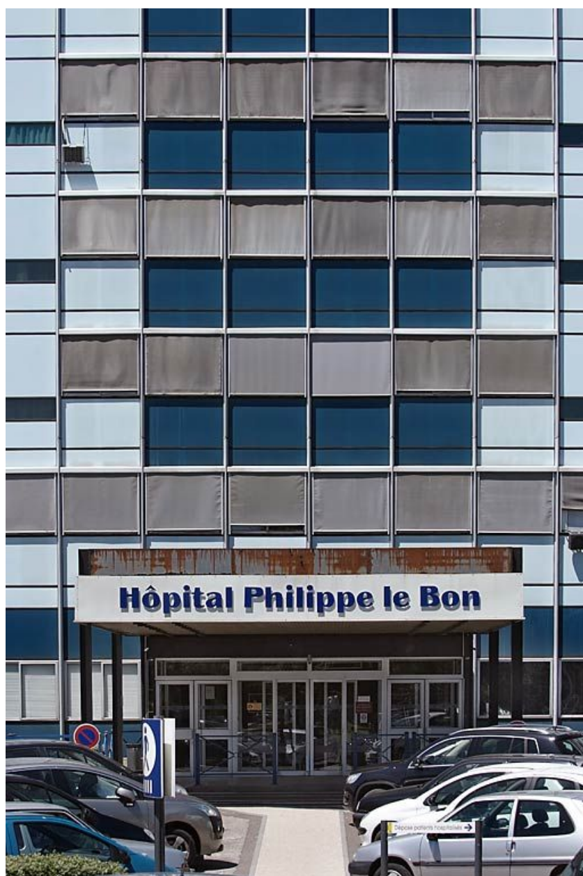
Bâtiment principal, détail de la façade.
