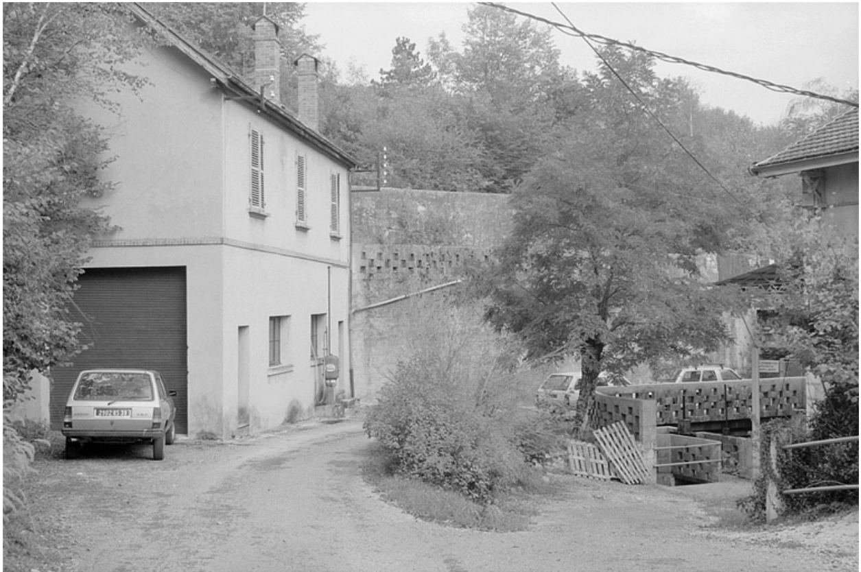
Logement d'ouvriers et chemin d'accès.
