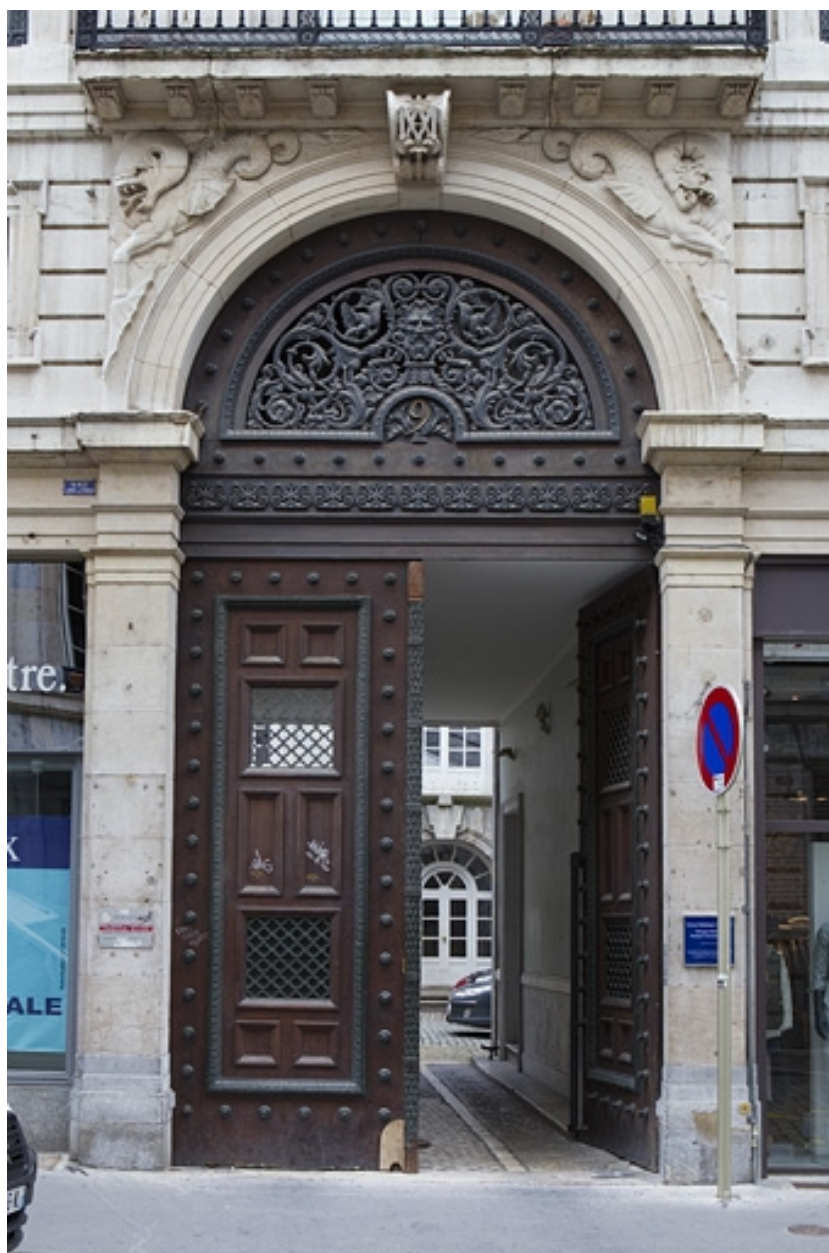
Portail d'entrée : vue d'ensemble.
