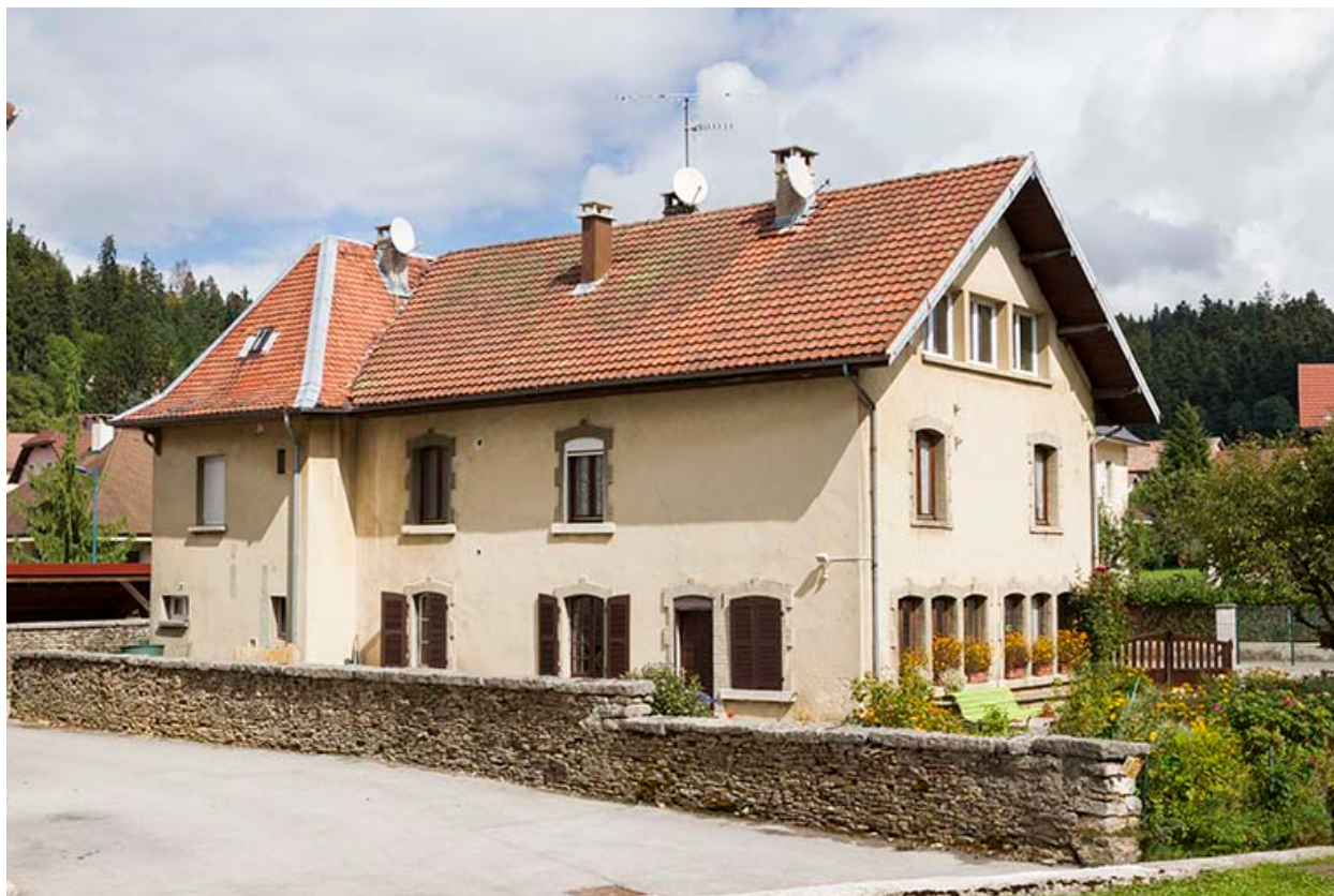
Façades postérieure et latérale gauche.
